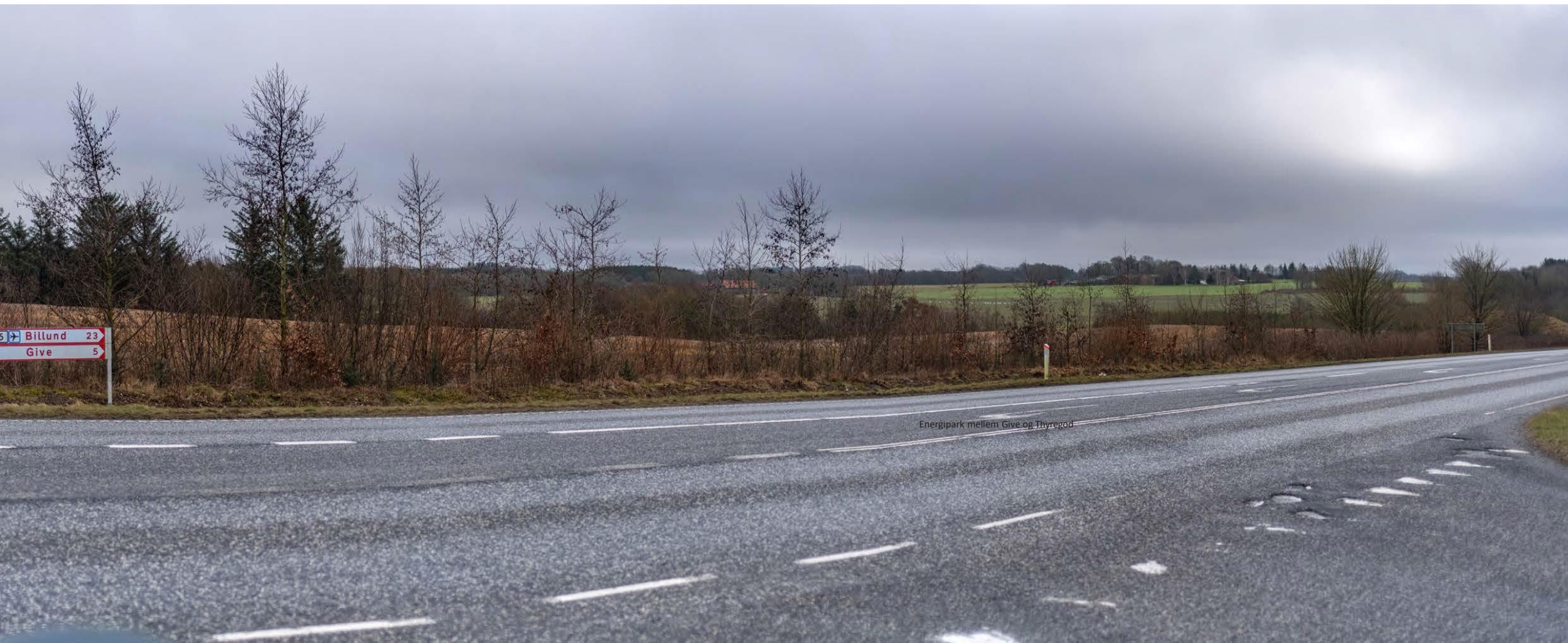
Thyregodvej/Givevej - eksisterende forhold
